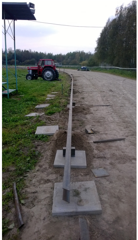
Uusi kisko hahmottuu.
