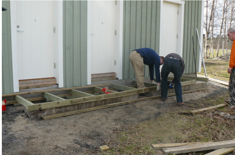
Huoltorakennus sai kevättalkoissa portaat. Pomona Kalle.
