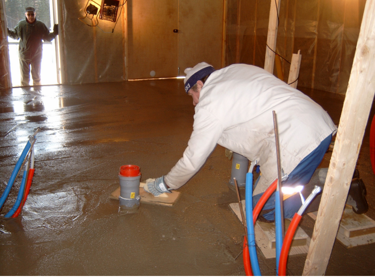
Matti Hiltunen tasoittaa lattiaa. Ovella kurkkii Salovaaran Kalle.
